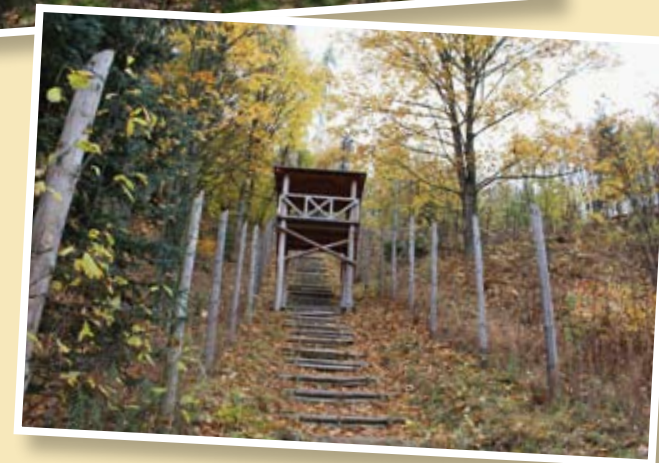
„Mauthausenské schody“ před rekonstrukcí v roce 2014 a opravené schody v roce 2018
