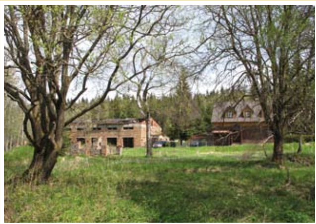
Hornická převlékárna na Rovnosti
